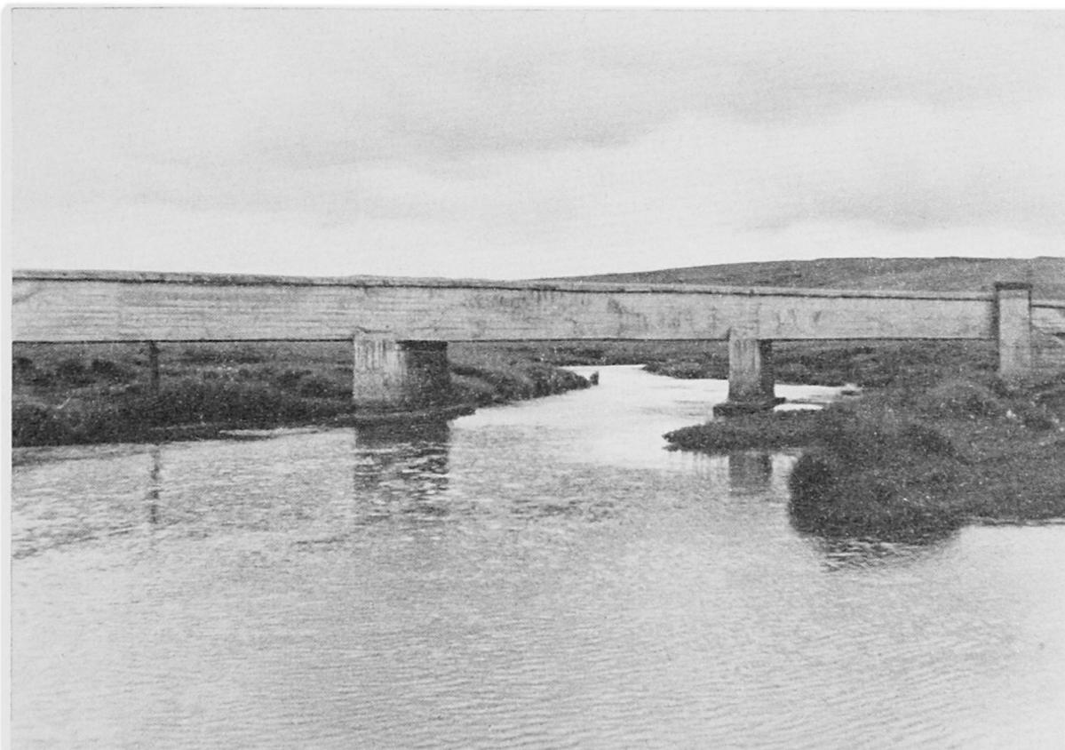
Abb. 3: Die Heißwasserleitung quert als moderner Aquaedukt einen Fluß. Täglich fließen rund 30 000 m<sup>3</sup> Heißwasser durch den Leitungsquerschnitt.
