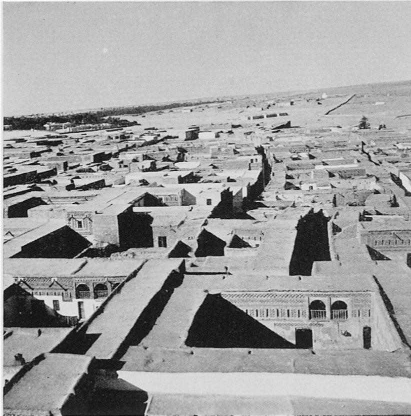
Abb. 1: Tozeur Blick über einen Teil der Siedlung. Die Hausterrassen sind von einem niedrigen Mauerbord umzogen. Die Fassaden gegen den Hof hin sind von Mauerschlitzen durchsetzt, zeigen Arkaden und sind im unteren Teil oft geweißt.
