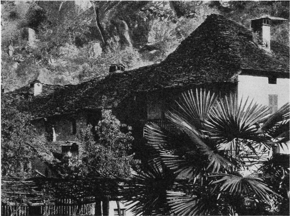
Fig. 4. Toits de dalles: San Vittore (Mesolcina)
