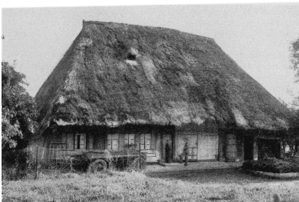
Fig. 1. Dernier toit de chaume (paille et roseaux) du canton de Berne, à Tschugg (1727)
