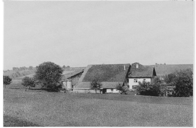
Abbildung 4. Ergoltingerhof, Ansicht von Süden
