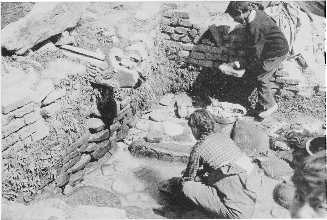
Abbildung 2. Quellfassung . Es handelt sich um eine kleinere Anlage östlich von Thecho (südlich des Kartenrandes), jedoch genau an der im Text beschriebenen Kontaktfläche von Mergeln und Schottern. Außer dem schön behauenen Wasserspeier beachte man auch die flachen Steine im «Trog», auf welchen die Wäsche durch Aufklatschen gereinigt wird. Töpfe zum Wegtragen von Verbrauchswasser. Aufnahme HB März 1971
