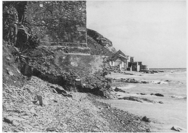
Foto 2: Wellenbedrängte Gebäude am östlichen Ortsausgang von Tarifa.
