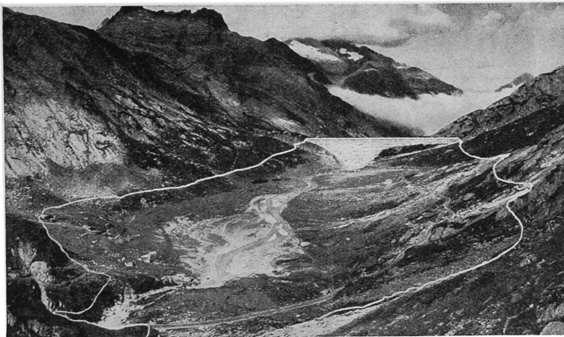
Der Räterichsboden unterhalb der Grimselsperren. Blick talabwärts. Die weiße Linie gibt die Grenze des künftigen Stausees an
