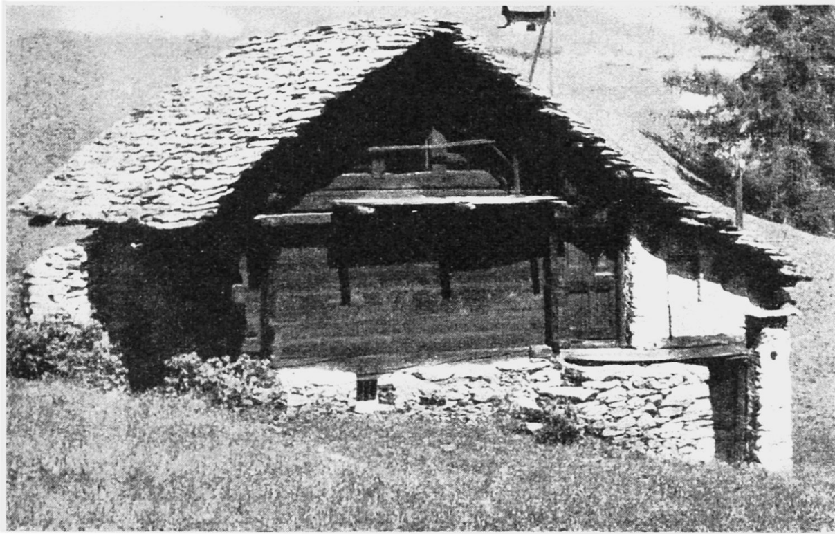
Abb. 25 „Maggiataler Block“ in Cimalmotto mit sekundärem Steinanbau (Treppenhaus)
