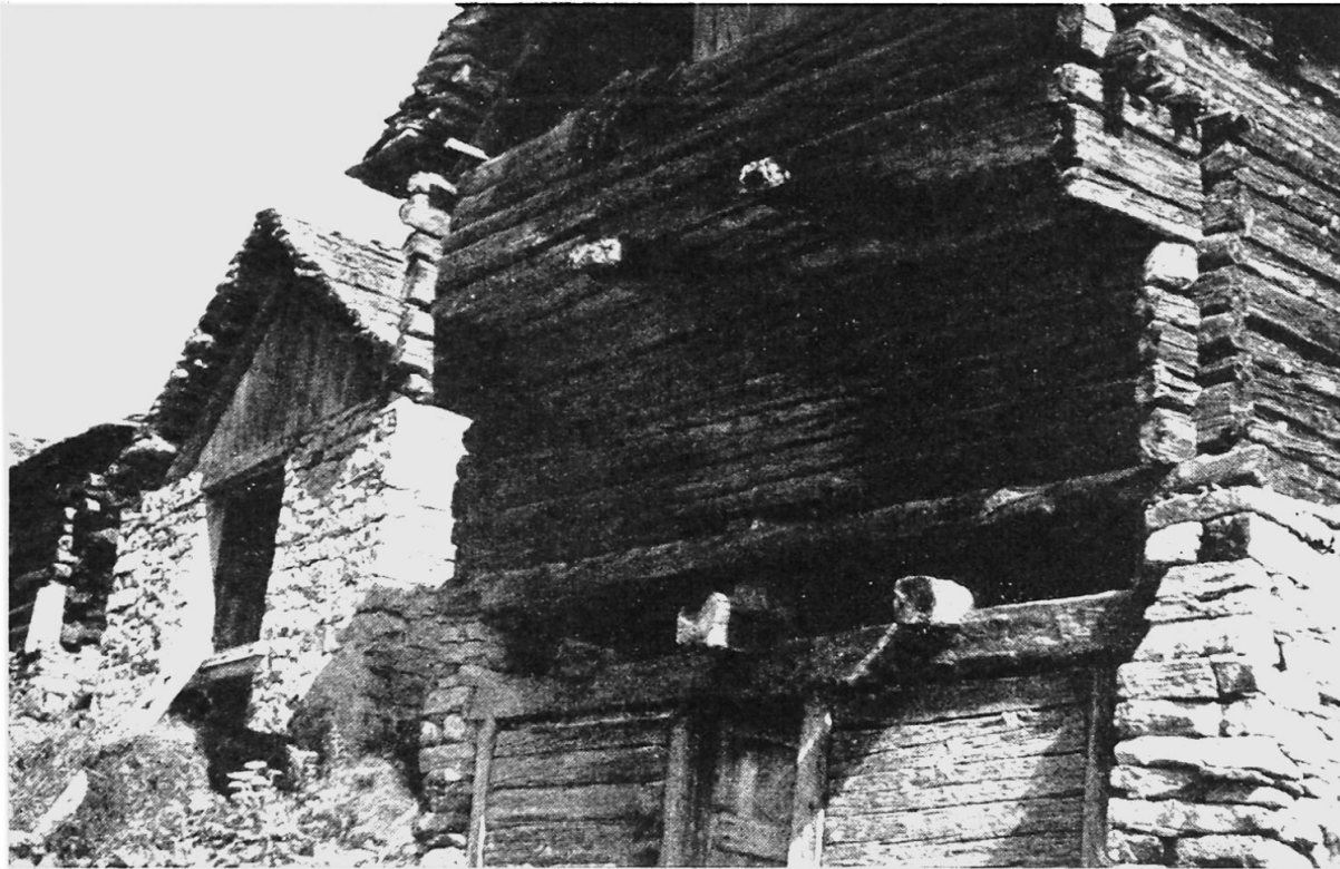
Abb. 31 Alter, gehobener Gurinerstadel im Verderr. Über dem Mittelstützel ist die Gefügelücke für die ehemaligen Dresch-Tennenbretter sichtbar
